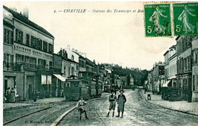
Le tramway à Chaville, en traction par une locomotive Mékarski.
