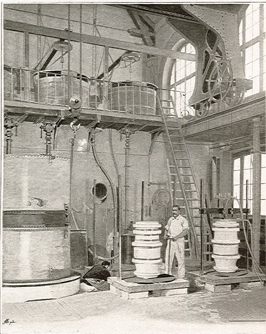
Atelier du grand coulage.
